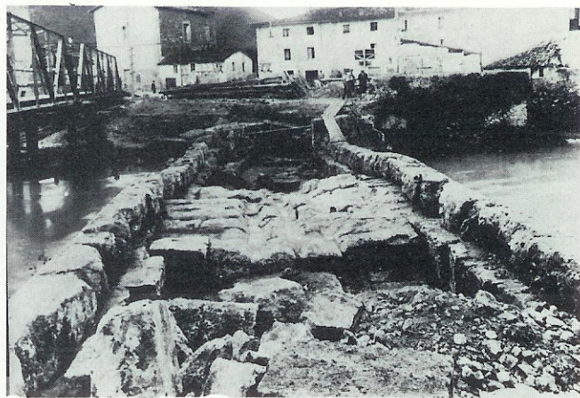
48. - Il ponte durante i lavori del parziale smontaggio.
