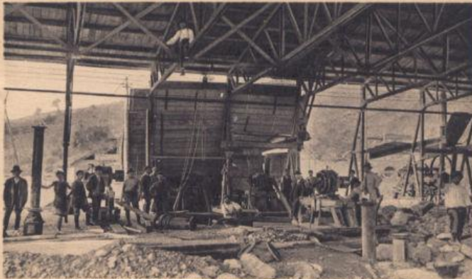
Centrale idroelettrica: Installazione di pompe centrifughe per l'assorbimento di potenti infiltrazioni d'acqua nelle fondazioni
